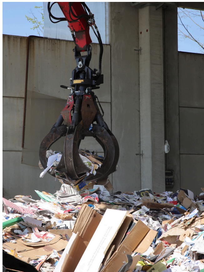
Impianto di selezione della carta Pessacollo, Piosasco
